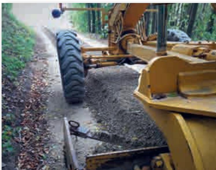
2013 durch die Ernst Frey AG. Einzelne Wegabschnitte wurden anstelle der ursprünglich geplanten Oberflächenbehandlung (Bitumen/Splitt-Auftrag) mit einem Belagshocheinbau (7cm ACT16) versehen, wodurch bei moderaten Mehrkosten eine deutliche Verbesserung der Tragfähigkeit resultiert.
