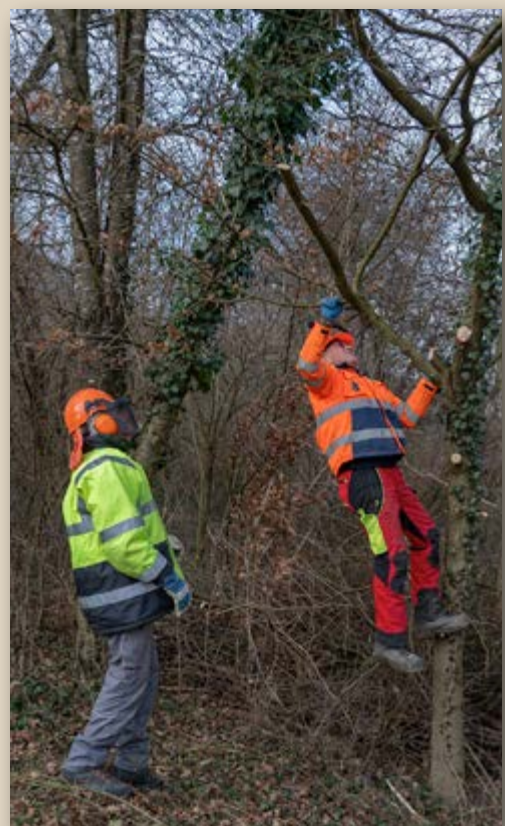
Arbeiten am Weiher
