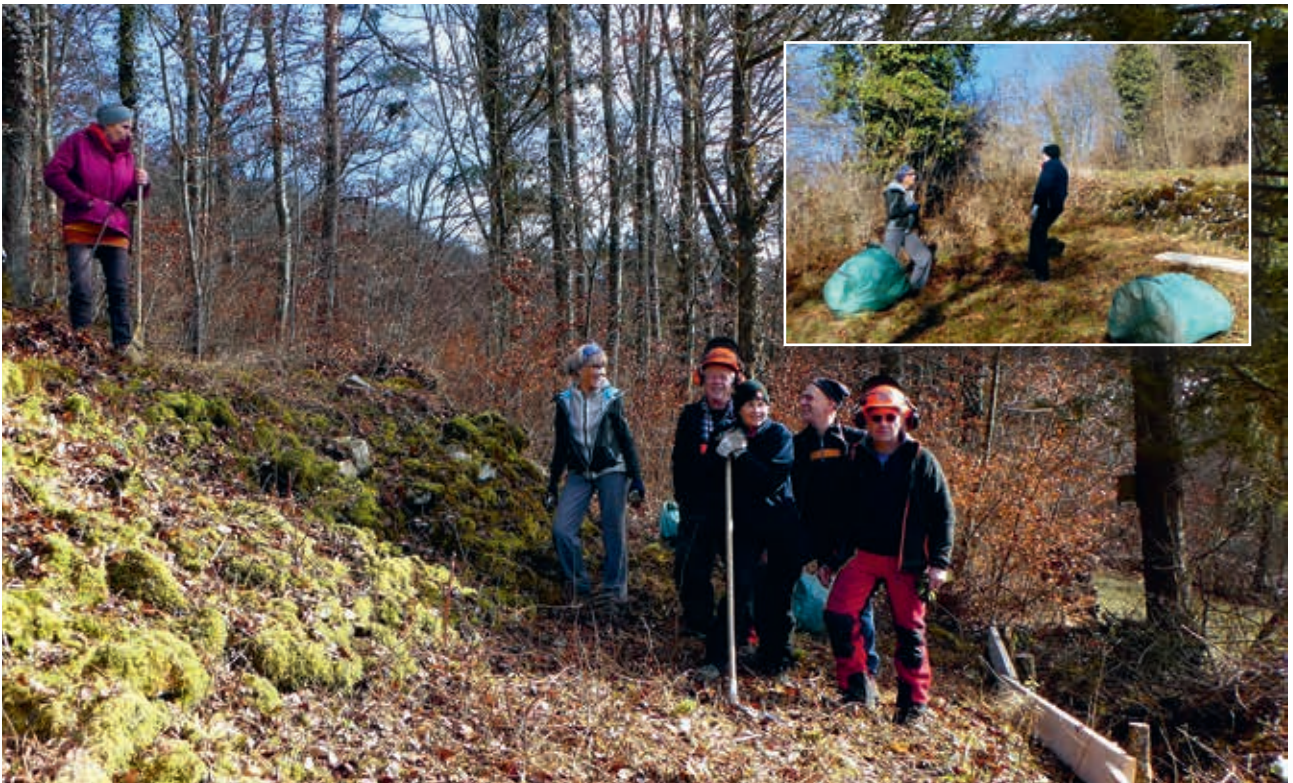
Absturzsicherungen schützen vor Steinschlag und halten noch brauchbare Steine für den Wiederaufbau zurück.
