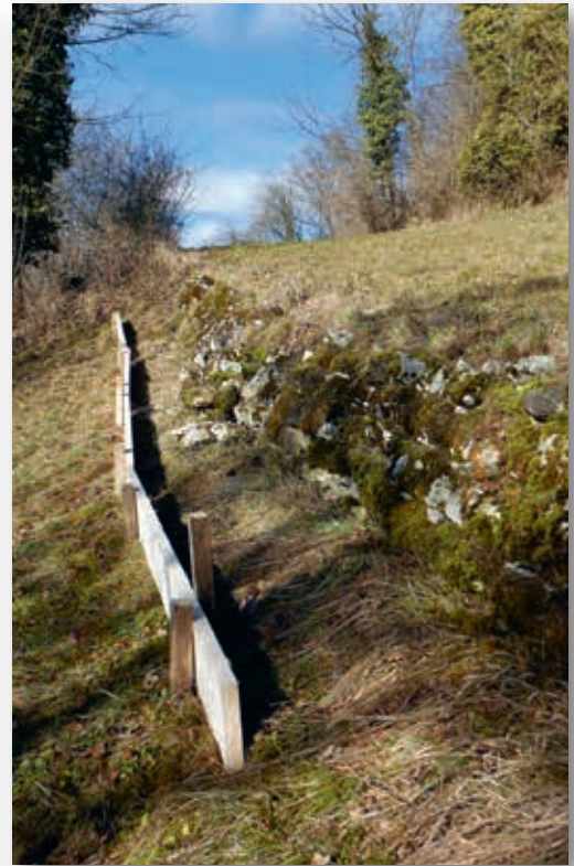
Absturzsicherungen: Schutz vor Steinschlag
