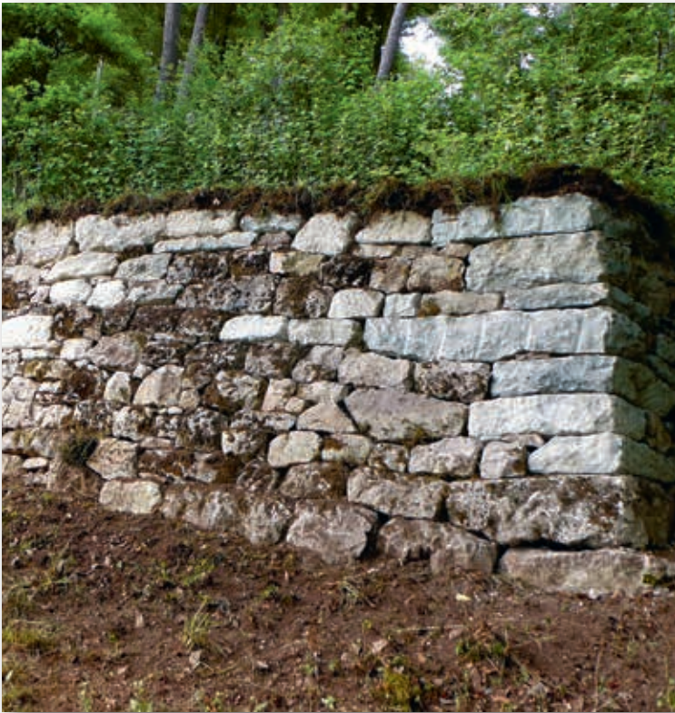
Die erste Trockenmauer wurde repariert. Die Sanierung der verbleibenden Mauern wird in den nächsten Jahren fortgesetzt.
